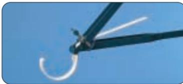
**3.** Оба крайних кронштейна устанавливаются на расстоянии около 150 мм от краев крыши. Далее натяните шпагат между наружными концами этих кронштейнов. Остальные кронштейны устанавливаются с шагом около 600 мм и крепятся гвоздями с гальваническим покрытием.
