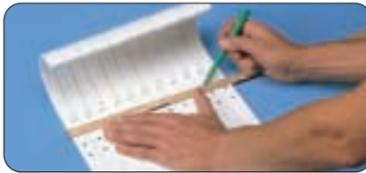
**2.** Согните крепежные кронштейны с помощью инструмента для сгибания. Кронштейн должен быть согнут таким образом, чтобы после сборки передний край сточного желоба был примерно на 2 мм ниже заднего.
