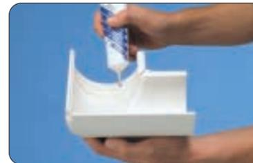
**17.** Желоб с приклеенным уголком устанавливаются в кронштейнах. Далее клей наносит на вторую внутреннюю часть уголка и следующий желоб соединяют с уголком.
