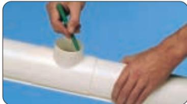
**10.** Мелкозубчатым полотном ножовки произведите два косых запила напротив друг друга. Зачистите края распилов.
