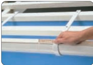
**14.** При соединении желоба необходимо следить за плотной стыковкой их концов. Затем на внутреннюю часть соединительного элемента наносятся 4 полоски состава «холодной сварки» шириной 5 мм, отступив примерно 15 мм от краев.
