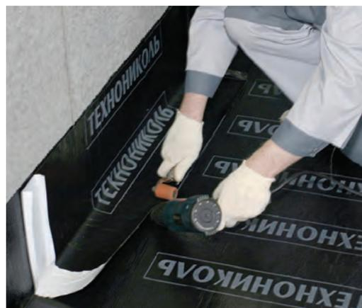
При применении Техноэласт БАРЬЕР ЛАЙТ возможно сразу укладывать на гидроизоляцию керамическую плитку на плиточном клее.
