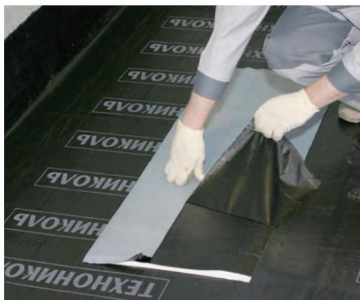
Затем край материала приклеивают к вертикальной поверхности так, чтобы край материала совпадал с краем загрунтованной поверхности.
