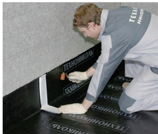
Удаляют антиадгезионную пленку с оставшейся части заготовки, которая клеится на горизонтальную поверхность.
