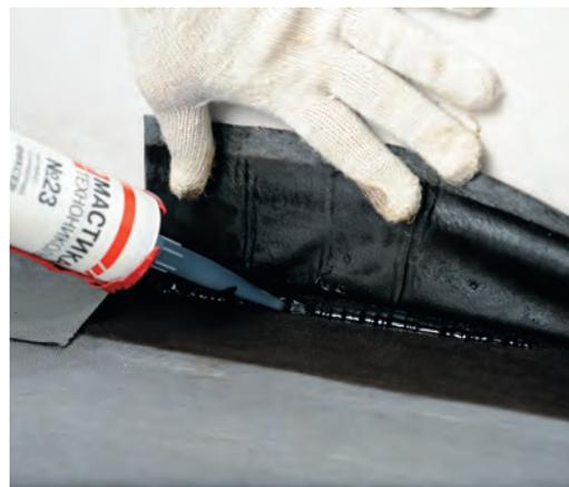
При устройстве гидроизоляции из самоклеящихся материалов Техноэласт БАРЬЕР (БО), Техноэласт БАРЬЕР ЛАЙТ особое внимание необходимо уделять выполнению узлов сопряжения с различными конструкциями (стенами, круглыми трубами), оформлению внешних и внутренних углов гидроизолируемого помещения.
