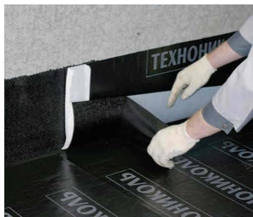
На место перехода с горизонтальной поверхности на вертикальную укладывают валик из мастики ТЕХНОНИКОЛЬ №23 (Фиксер). Мастику укладывают с помощью пистолета.
