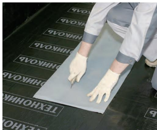
Снимают пленку с части материала, которая будет приклеиваться на вертикальную поверхность.
